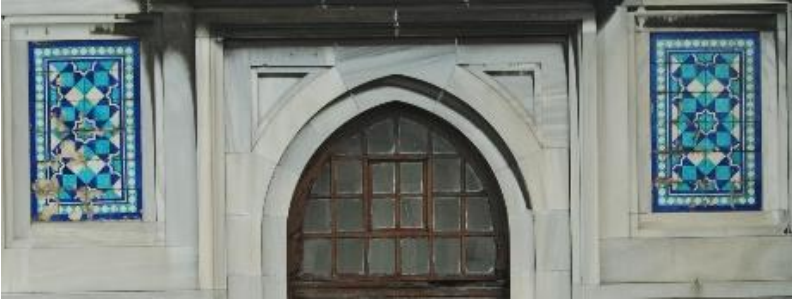
Fotoğraf 5: Büyük Postane; sır atmaları, bünyeden derin kopmalar (restorasyondan önce, Ebru Köse arřivinden).
