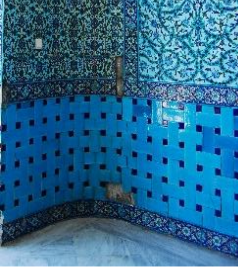
Fotoğraf 3: Çapa Fen Lisesi girişi iç cephe, eksik çini, elektrik anahtarının çini pano- daki yerleşim yeri (Ebru Köse arşivinden).
