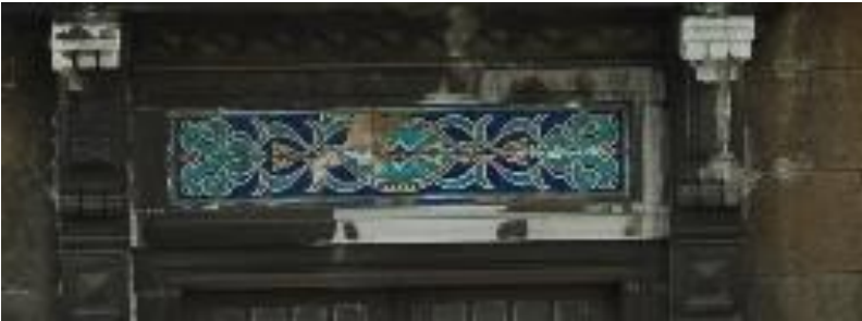
Fotoğraf 6: Büyük Postane; sır atmaları, bünyeden derin kopmalar (restorasyondan önce, Ebru Köse arřivinden).
