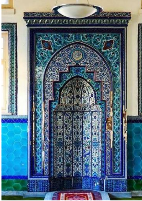
Fotoğraf 17: Sultan Ahmet Cezaevi Mescidi eksik çini, kırılmalar ve bünyeden derin kopmalar.
